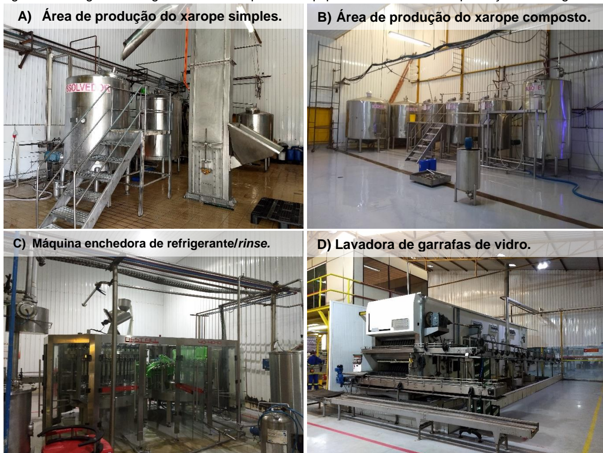
Figura 24 - Registros fotográficos das máquinas e equipamentos do setor de produção de refrigerante.
