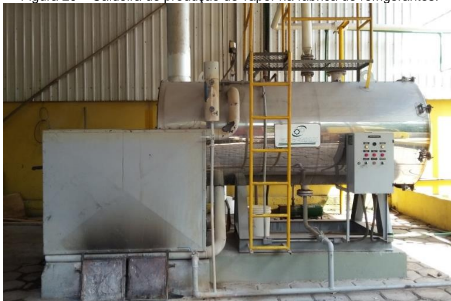
Figura 20 – Caldeira de produção de vapor na fábrica de refrigerantes.
